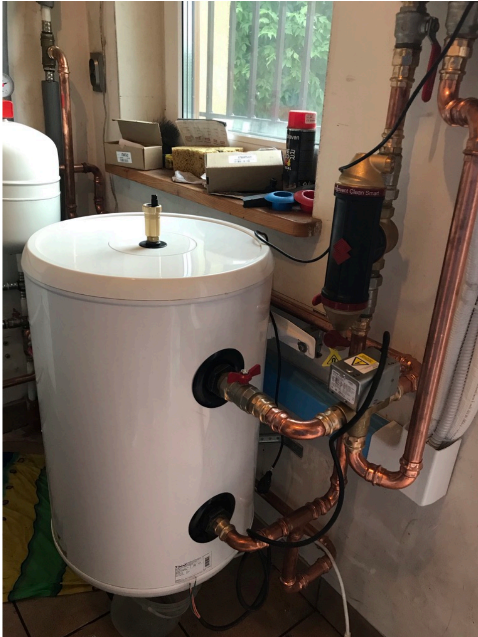
Uzbrojony zbiornik buforowy 60 litrów, podczas prac instalacyjnych. Widoczny jest również dodatkowy zawór trójdrogowy, do przełączania obwodów.
